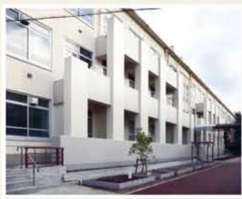
アウトフレーム工法による耐震補強(鏡山小)
