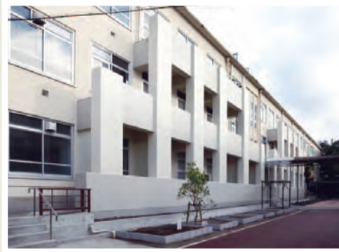
アウトフレーム工法による耐震補強(鏡山小)
